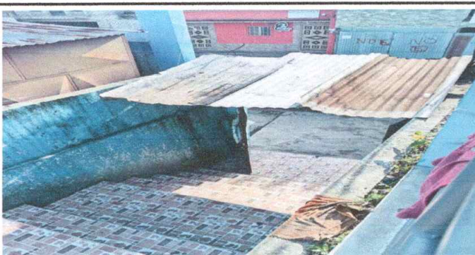
Foto 3: sustitución de lamina, por lámina troquelada slizinc calibre 26
