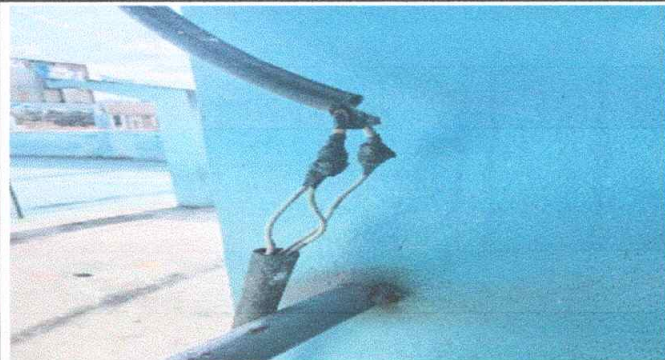
Foto 8: Sustitución de cableado eléctrico
