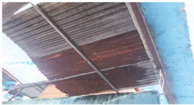
Foto 2: sustitución del de la estructura de soporte de madera por metal.
