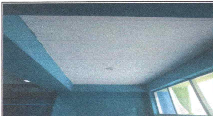
Foto 8: Sustitución de lámparas tipo Led
