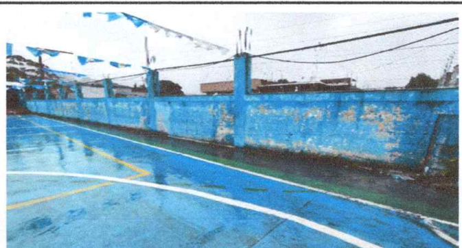
Foto 4: Aplicación de impermeabilizante en el interior y exterior del muro perimetral del establecimiento educativo.
