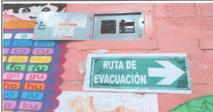
Foto 7: Sustitución de tablero de flipones
