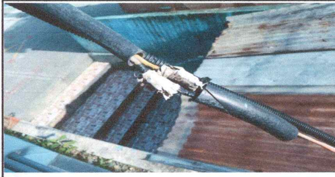
Foto 6: Sustitución de ducto eléctrico + accesorios
