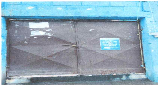
Foto 1: sustitución de porton de metal en la entrada principal
